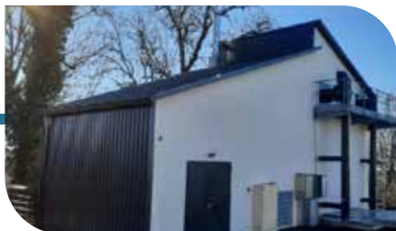
Mise en service du réseau de chaleur bois-énergie à Saint-Pierre-de-Trivisy
