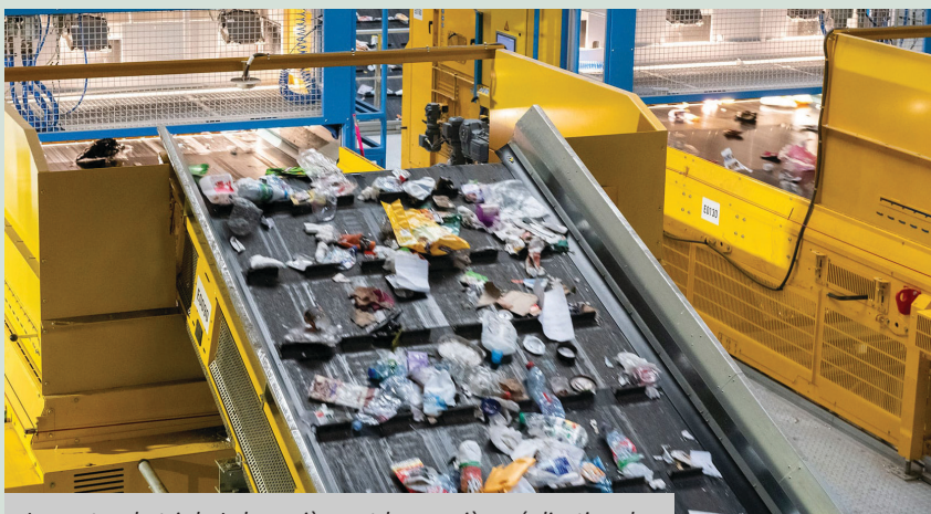
Le centre de tri de Labruguière est la première réalisation du projet TRIFYL HORIZON 2030
