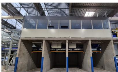
3. Alvéoles de stockage des recyclables
